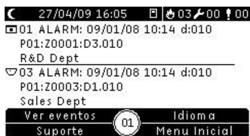
Figura 4: Indicação de alarme de incêndio no ecrã LCD do painel de controlo
